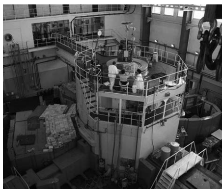
1. ábra • A Budapesti Kutatóreaktor. Körülötte láthatók a sugárvédelemmel ellátott kísérleti berendezések. A jobb oldalon alul a neutronvezetők védelme helyezkedik el. (forrás: www.aeki.kfki.hu )
