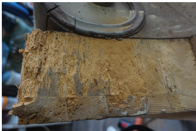
5. kép. Rovarkárosodott oltárelem
