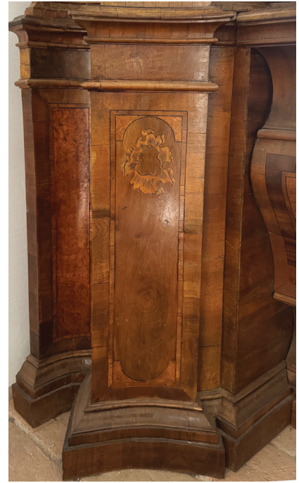
12. kép. Öregített furnér- és profilkiegészítések a sellakpolitúr felhordása után
