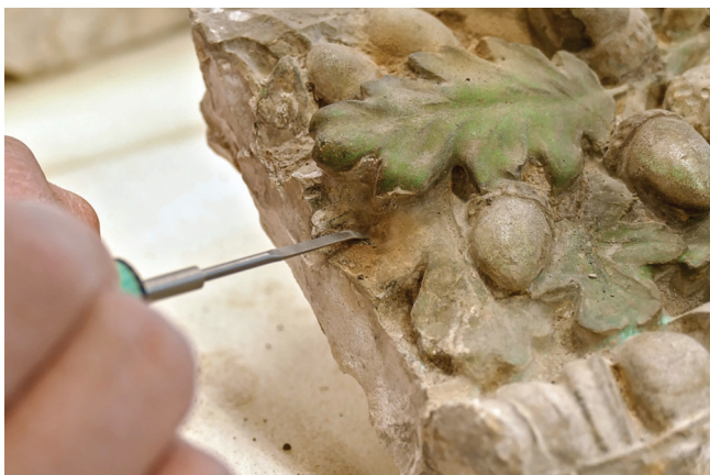
8. kép. A plasztikába beült rideg, barna színű anyag sorvasztása ultrahangos depurátorral
