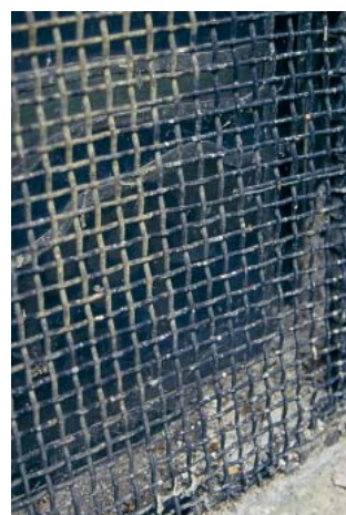
15. kép. A sűrű drótfonatot váltotta fel a ragasztott biztonsági üveg a zebegényi templomban.
