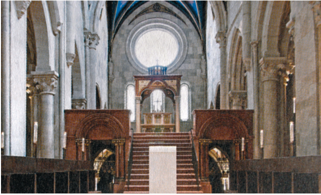
3. kép. A apátsági templom mai semlegesített belső tere, a „megvakított” ablakkal. Már a baldachint is elbontották.
