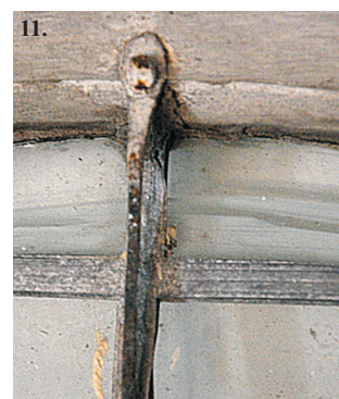
11. kép. A szélvasakat az ólomsínek elé helyezve a kerethez szegelték.
