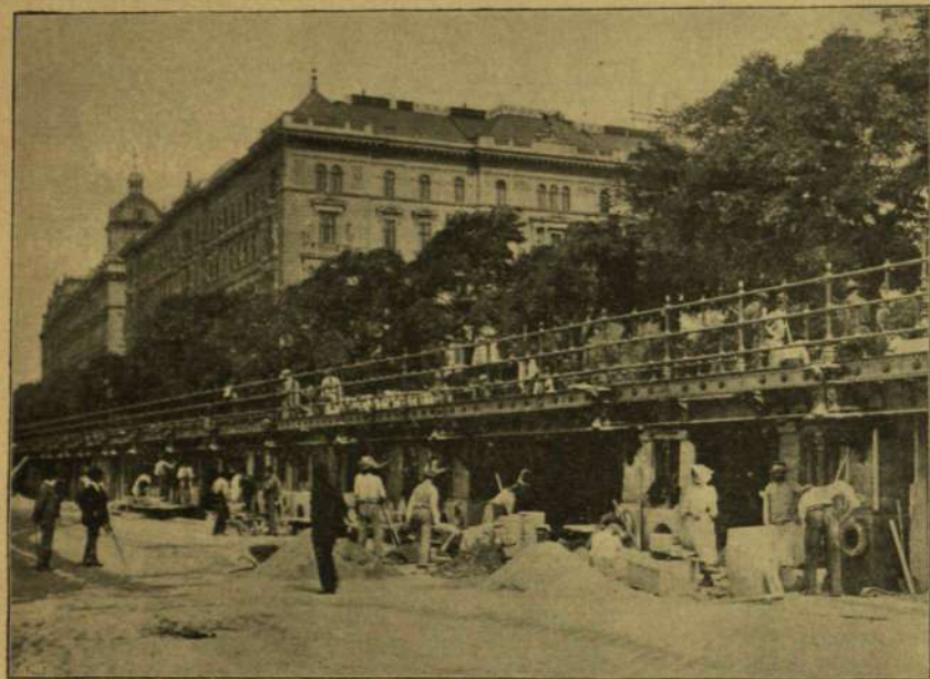
A VASÚT VIADUKTJÁNAK ÉPÍTÉSE.
