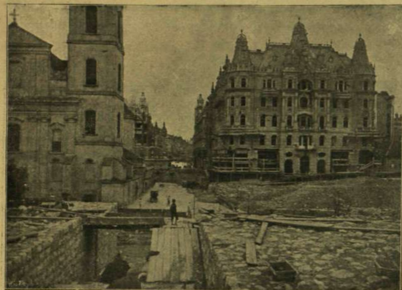
A PESTI OLDALI FÖLJÁRÓ ALAPOZÁSA AZ ÚJ ESKÜ-ÚT VÉGÉN.
