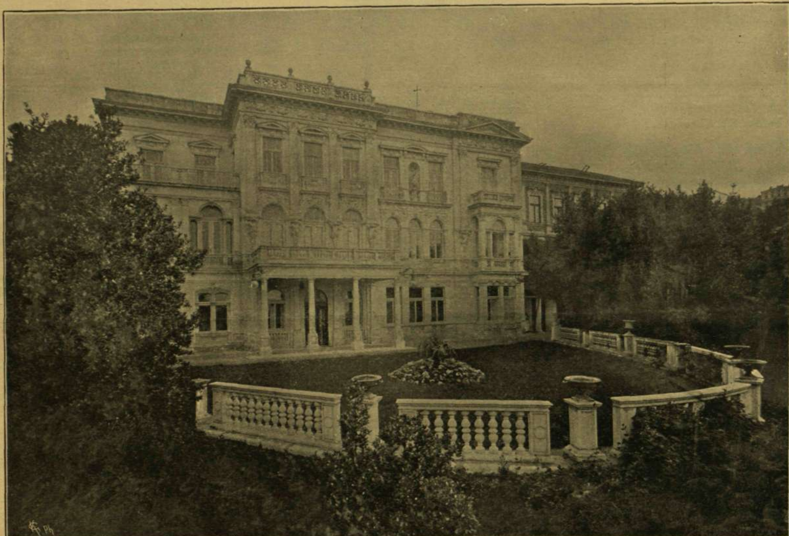
A VILLA GIUSEPPE FIUMÉBAN. — A kert felől! homlokzat.
