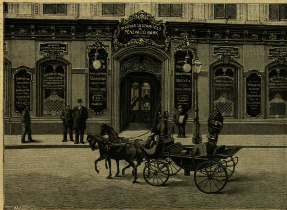
A LESZÁMITOLÓ ÉS PÉNZVÁLTÓBANK ÉPÜLETE A DOROTTYA-UTCÁBAN.
